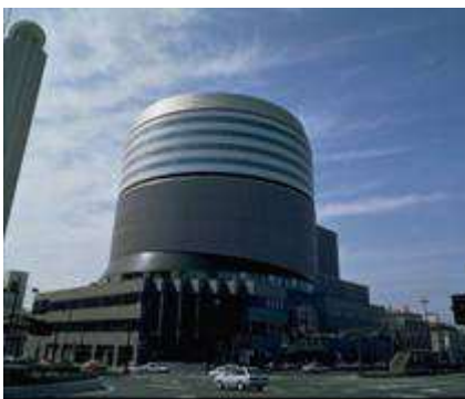
■岡山シンフォニービル(岡山市)■
