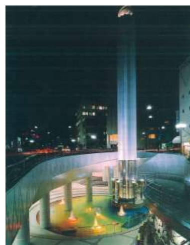
■ 城下地下交通広場（岡山市） ■ （城下地下広場）
