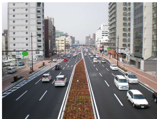
■久米東岡山線（岡山市）■
