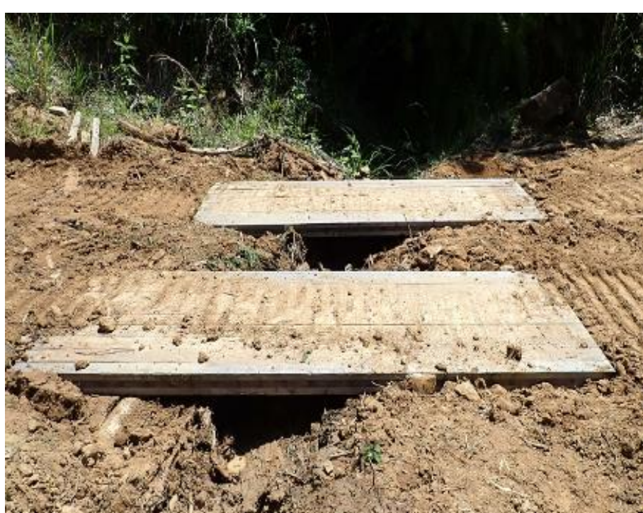
土木用CLTの設置状況
