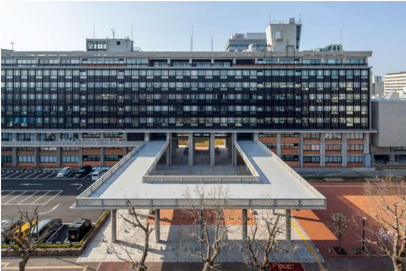
②本館北面 カーテン・ウォール、回廊 及びピロティ
