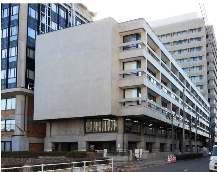
⑧西庁舎 北西面
