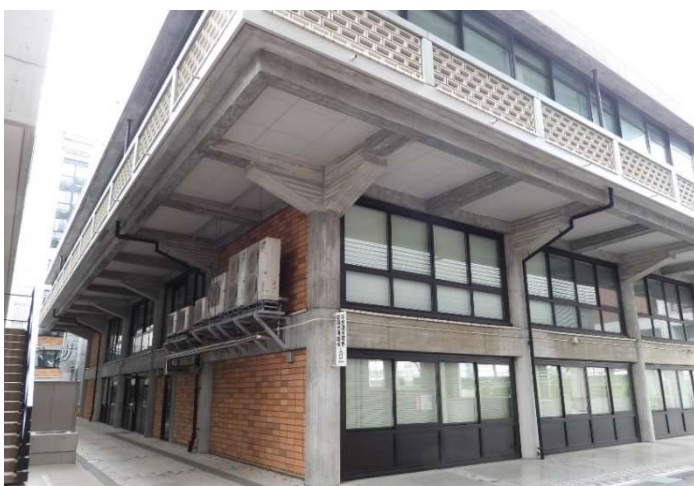
④本館南面 カーテン・ウォール、コンクリート打放し仕上の柱など
