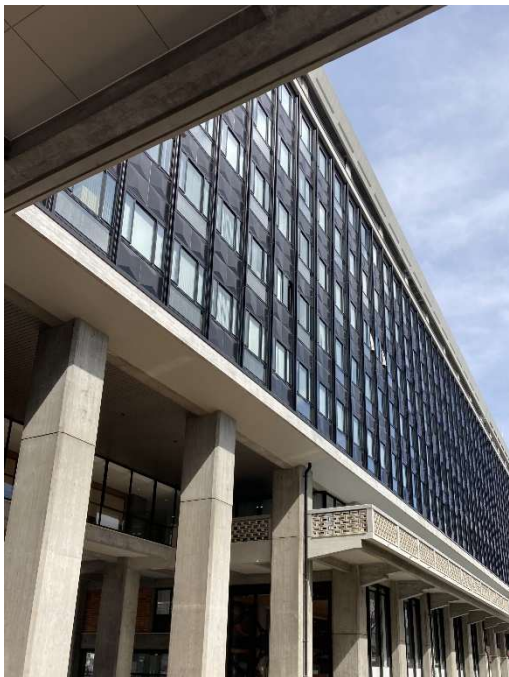
④本館南面 カーテン・ウォール、コンクリート打放し仕上の柱など
