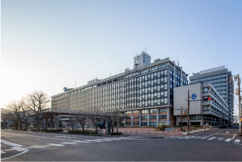
①本館及び西庁舎 北西面
