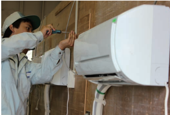
エアコン工事実習
