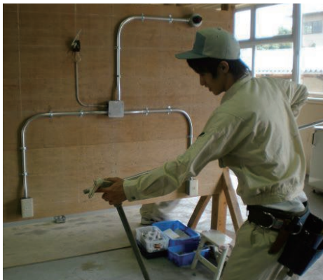
金属管工事実習
