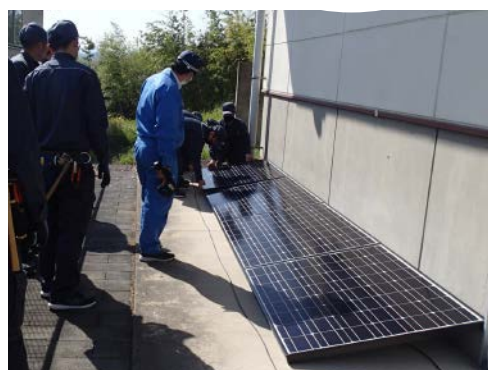
太陽光発電設備施工実習
