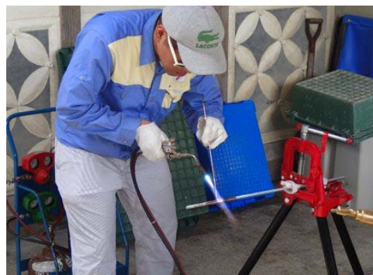
冷媒配管溶接実習
