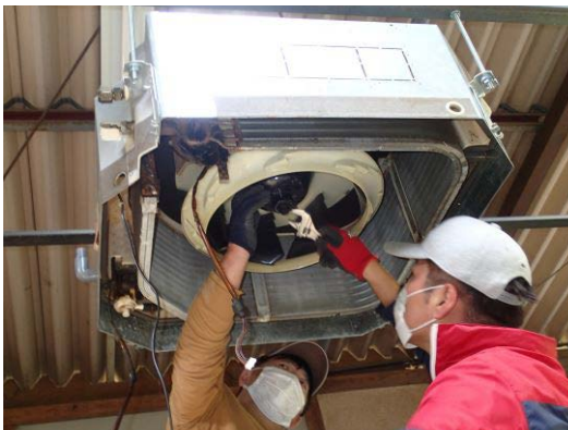
天井カセット型エアコン点検
