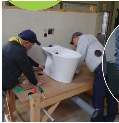
衛生器具設置
