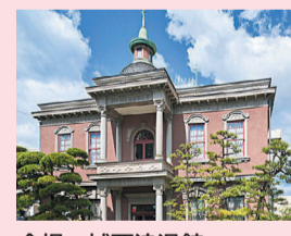
会場：城西浪漫館(中島病院旧本館)
