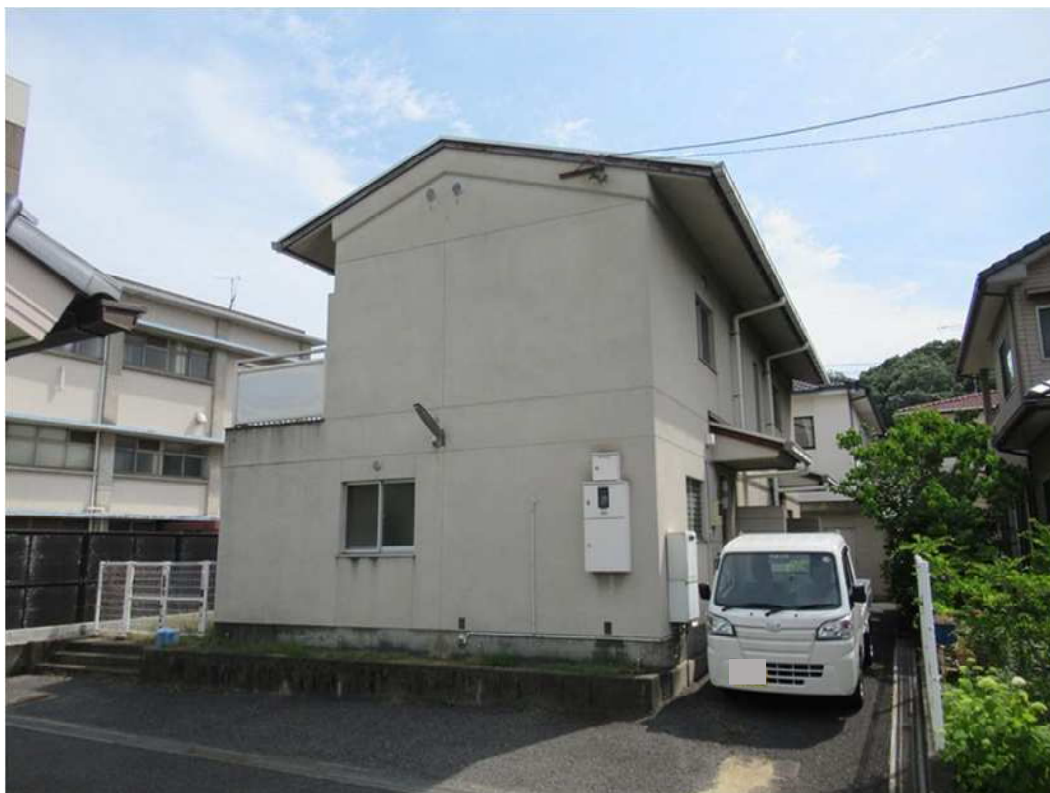
北東側より撮影
