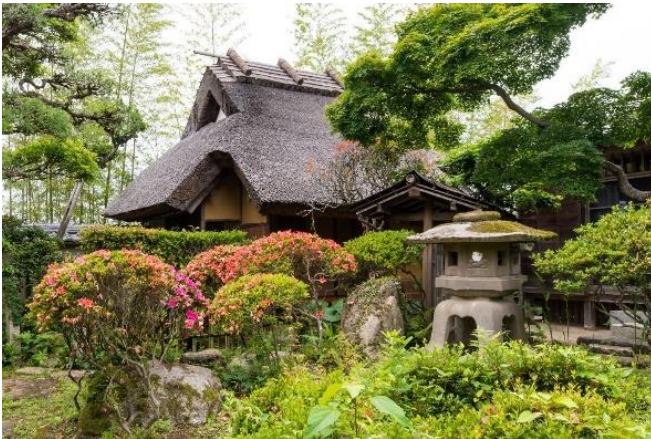
⑤ 如是庵外観（南東から）
