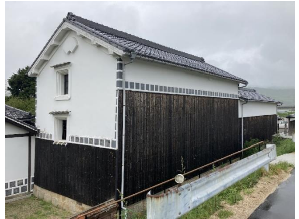
⑥ 北蔵・南蔵外観（南東から）
