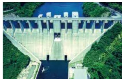
平成17年3月に完成したダムで、県内3番目の貯水量を誇り、コンクリートの重さで水圧に耐える重力式コンクリート型式ダムです。国内初のラビリンス型（ジグザグ型）の非常用洪水吐を備えた美しいフォルムのダムで、ガラス張りの見学室から放流も見ることができます。一般開放も行っているため自由に見学でき、また管理所では、人氣急上昇中のダムカードももらえます。
