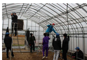
農業施設整備実習
