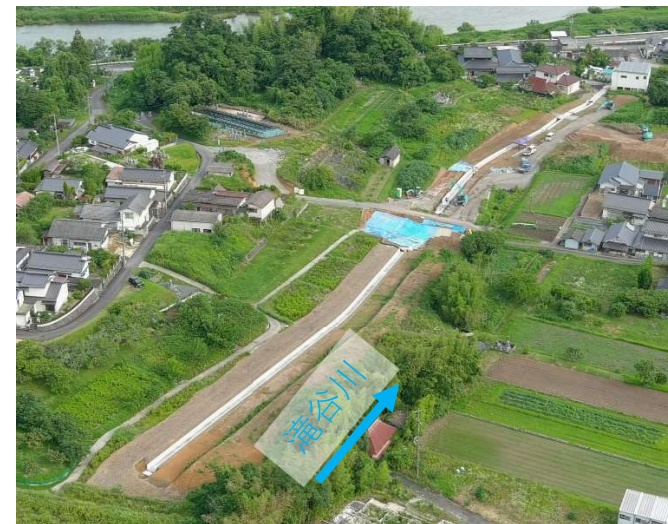
滝谷川改修状況
