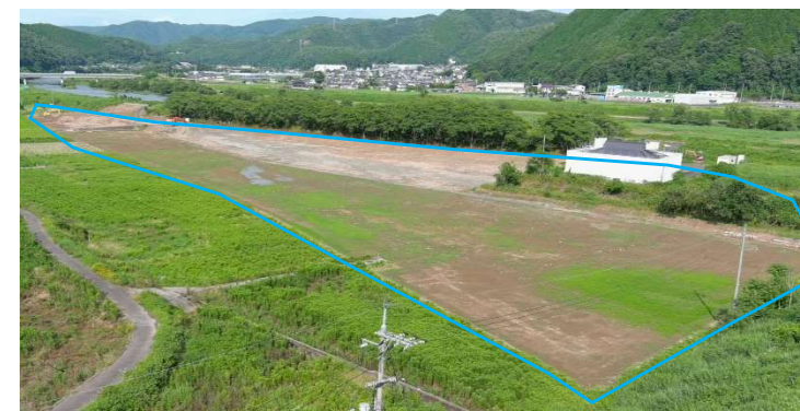
内水対策における遊水地掘削状況
