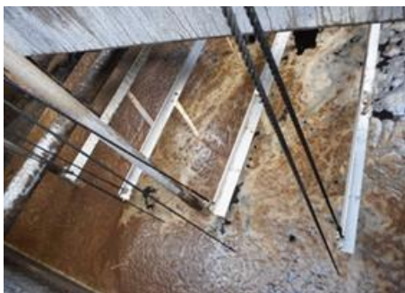
図3 曝気槽内の炭素繊維リアクター
