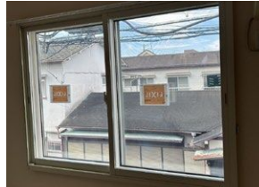
主居室の南側に内窓設置
