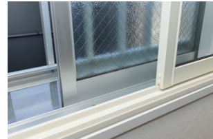
全住戸の内窓設置を実施
