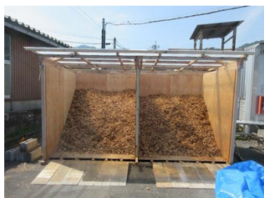
図1 改良した屋内チップヤード
