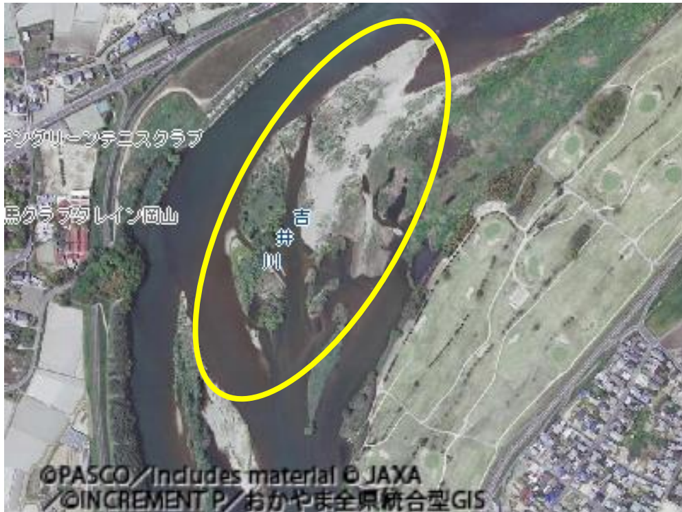
写真8 吉井川備前大橋下（河口から約13km）
