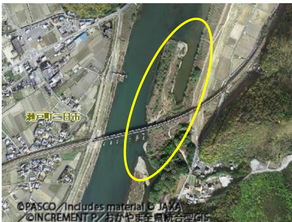
写真6 吉井川麒麟ビール取水塔東（河口から約21km）
