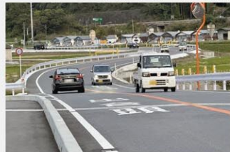
【整備後(バイパス)】
