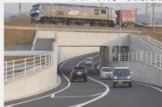
【整備後(バイパス)】
