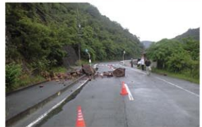
落石により通行規制となった道路
