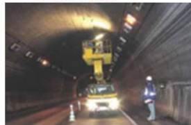
トンネル点検状況
