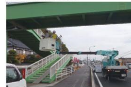
歩道橋点検状況
