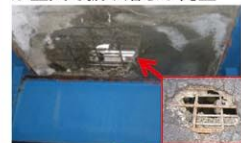
コンクリート床版の打ち換え・増厚
