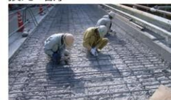
コンクリート床版の打ち換え・増厚
