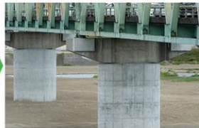
橋脚巻立による耐震対策
