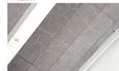
炭素繊維の接着を行いひび割れの進展を抑制
