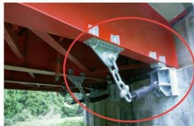
落橋防止装置による耐震対策
