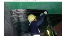
炭素繊維の接着を行いひび割れの進展を抑制
