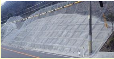
道路法面の落石対策
