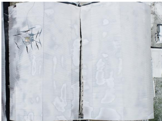
塗料散布直後の牛舎屋根
