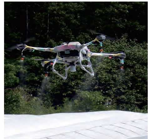
ドローンによる塗布作業
