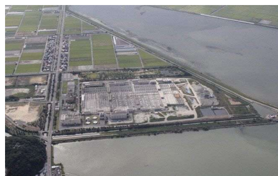
児島湖流域下水道浄化センター
