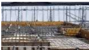
床下の基礎断熱
