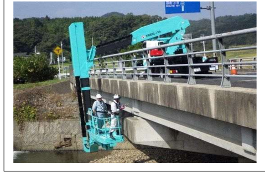
橋梁点検状況
