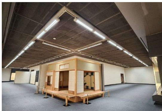
照明LED化改修工事(県立美術館)
