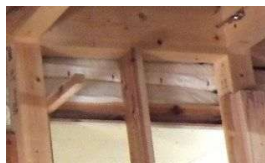
天井断熱材2枚重ね
