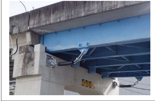
耐震補強状況
