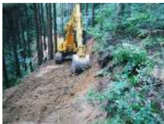
作業道の開設
