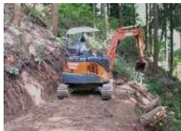
作業道の機能強化 （路面の補修等）
