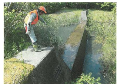
治山施設の点検
