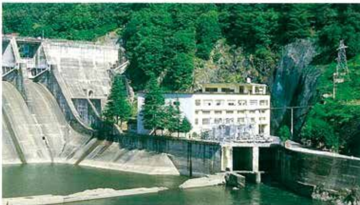
ダム直下の第一発電所
