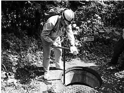
2ルート配水管路の切替作業状況
