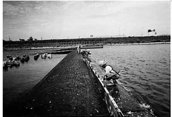
パネル設置作業状況
