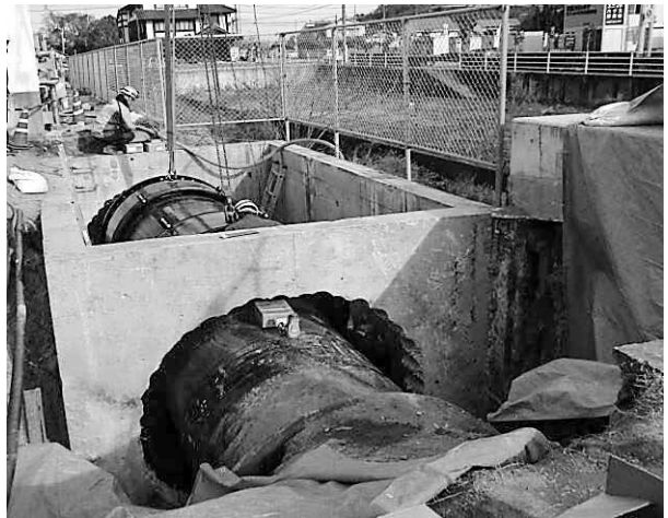
耐震化工事例：西之浦4期導水伸縮可とう管設置工事 地震が発生した際に管路の破損や漏水を防ぐため、伸縮可とう管を整備。
