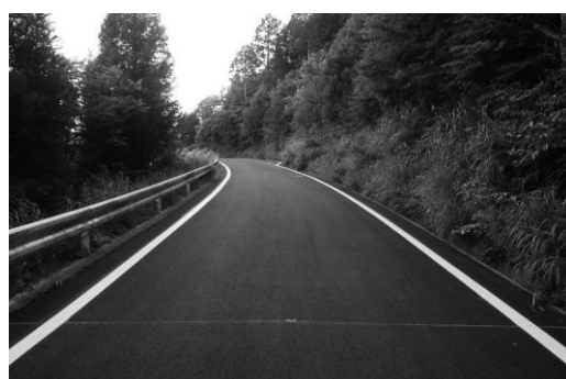
林道施設の整備（舗装）
