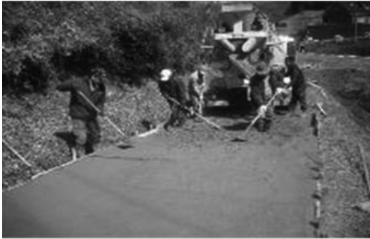
多面的機能支払(農道の舗装)
