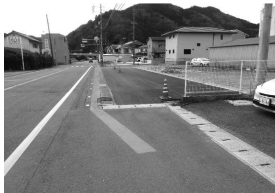
国道 3 1 3 号（整備後）
