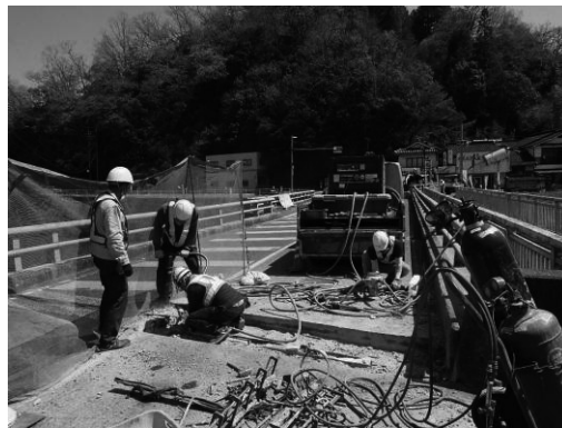
橋梁伸縮装置補修工事状況
