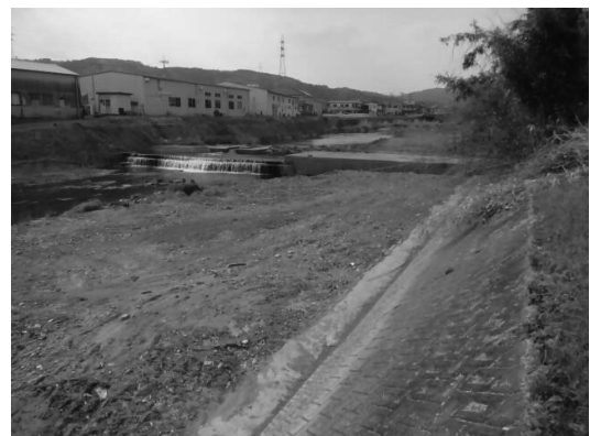
一級河川 宮川（実施後）
