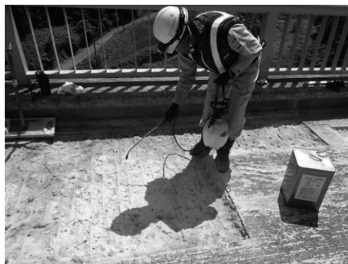
橋梁床版補修工事状況
