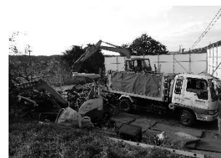
解体現場の様子
