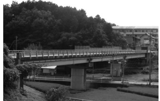
農道の保全対策(橋梁耐震補強)
