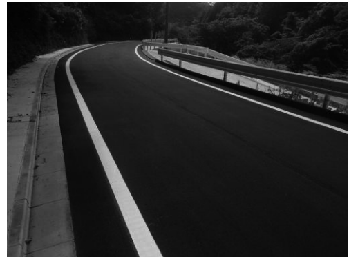
県道 余野上久米線（整備後）
