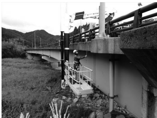
橋梁点検状況
