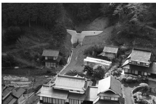
谷止工による荒廃森林の整備
