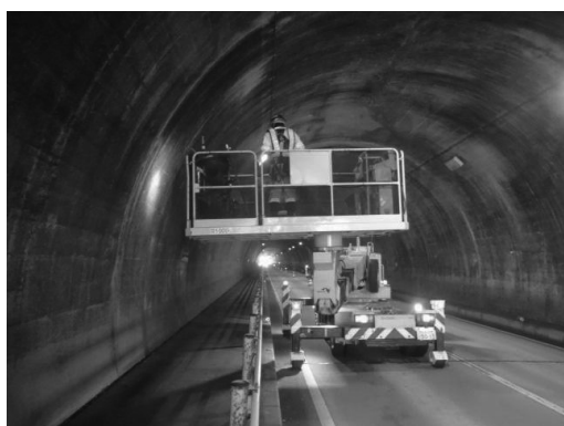
トンネル点検状況
