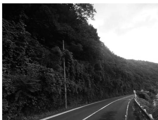
県道 津山柵原線 (整備前)
