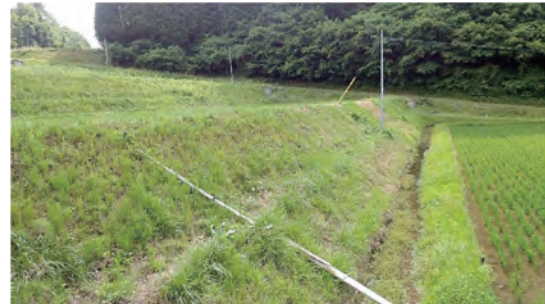
高梁市内の法面の大きく急傾斜な畦畔例
