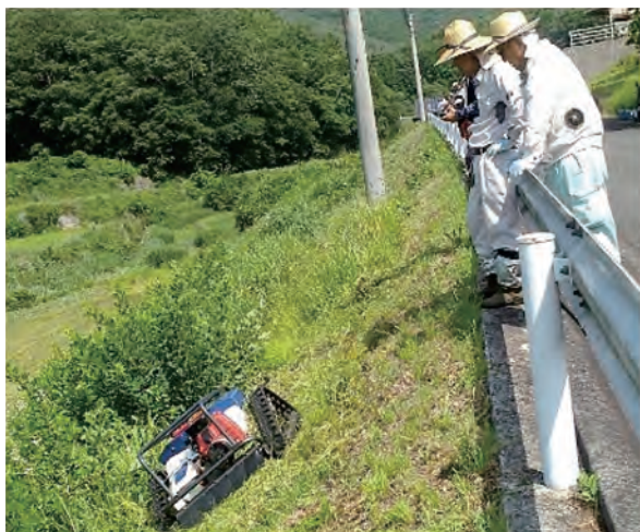
図3 ラジコン草刈機による草刈作業
