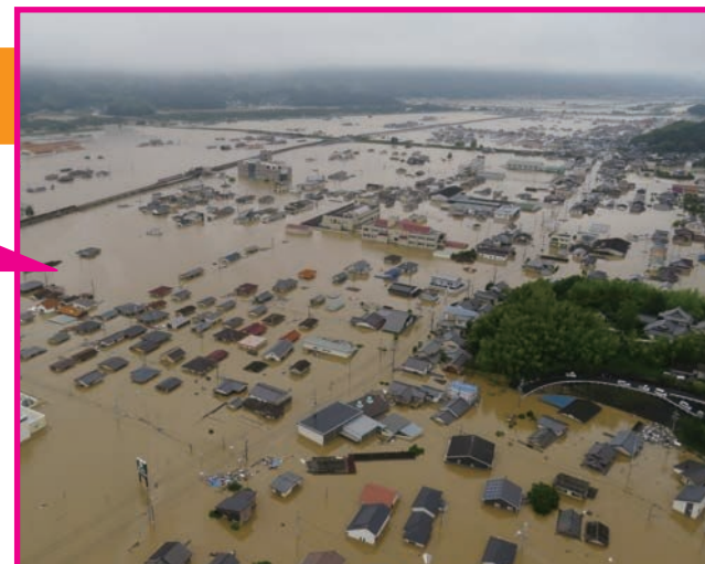
平成30年7月 倉敷市真備町 豪雨における浸水被害
