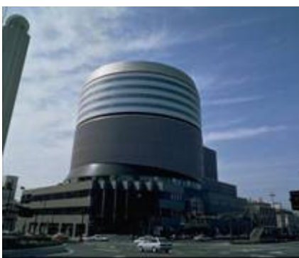
■岡山シンフォニービル(岡山市)■
