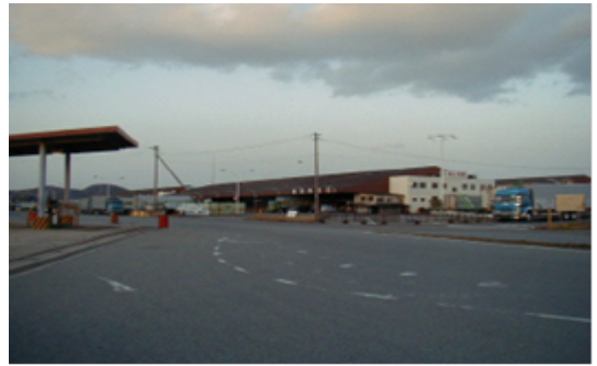
■岡山トラックターミナル（岡山市）■
