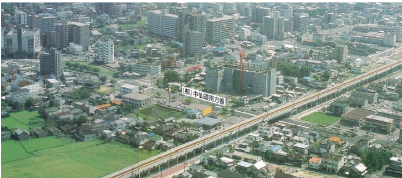
■JR宇野線大元駅付近（岡山市）■
