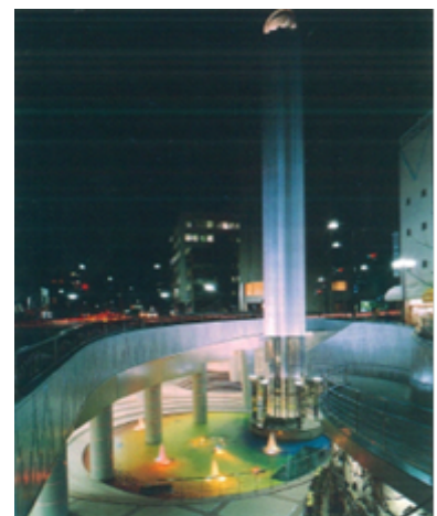
■城下地下交通広場（岡山市）■ (城下地下広場)
