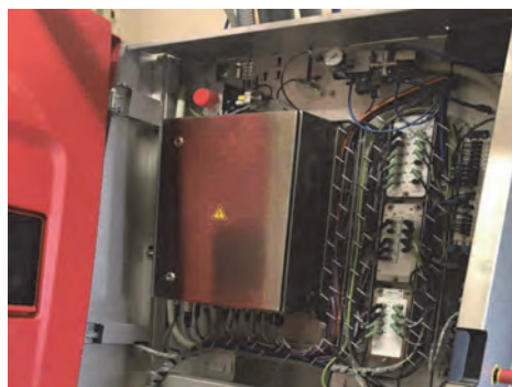
図1 搾乳ロボット内の配線（一部）
