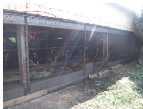
図4 設置したネットの様子
