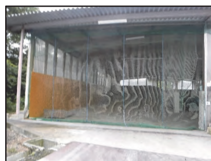
〔写真：堆肥舎への ネット設置例〕
