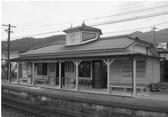
線路からみた新駅舎
