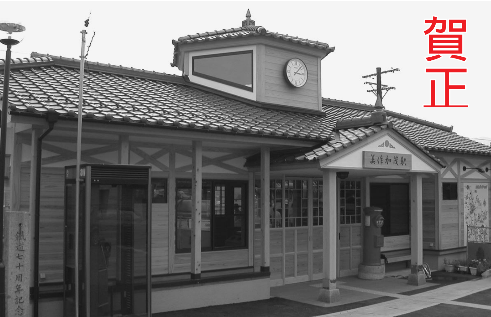
地域の木材利用施設「JR因美線・美作加茂駅舎」(加茂町)
