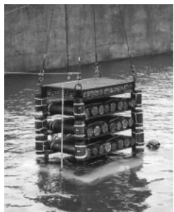
間伐材魚礁の設置状況
