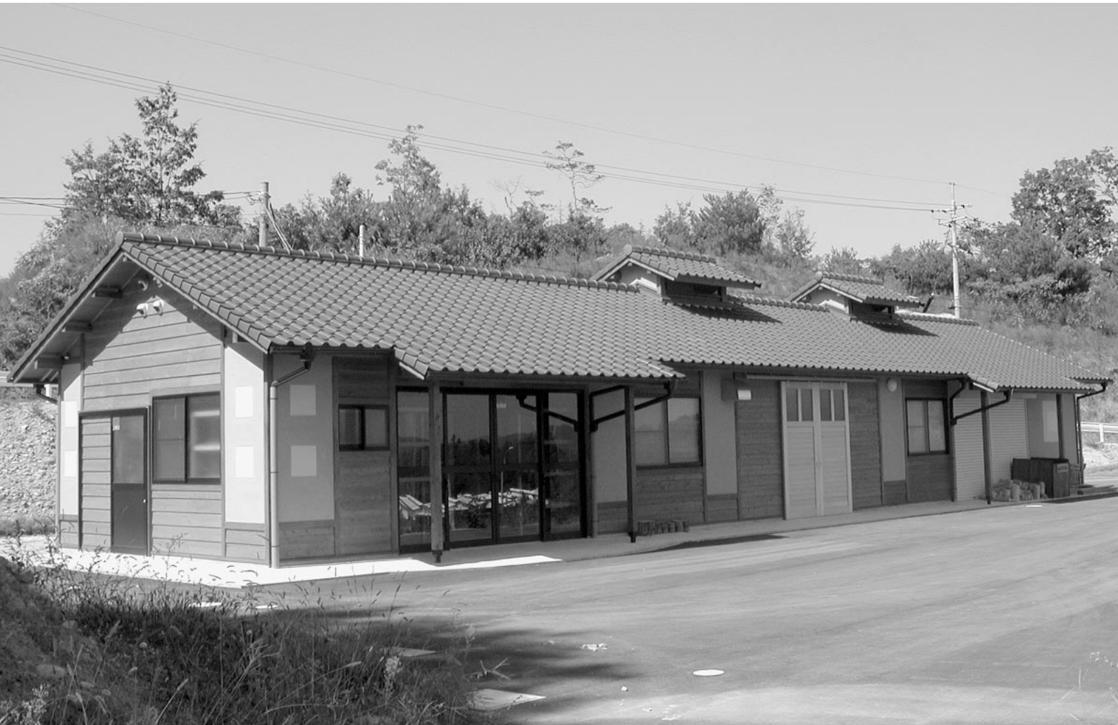
地域の木材利用施設「川上町民芸品等共同創作センター」(川上町)
