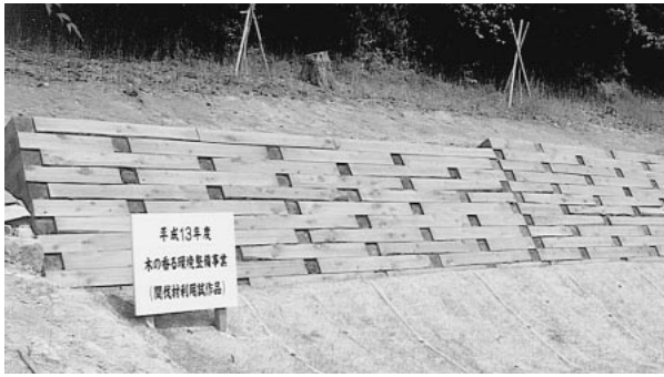
木製トンボ型 T字型 丸太土留工
