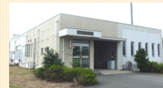
〈岡南飛行場電源局舎〉
