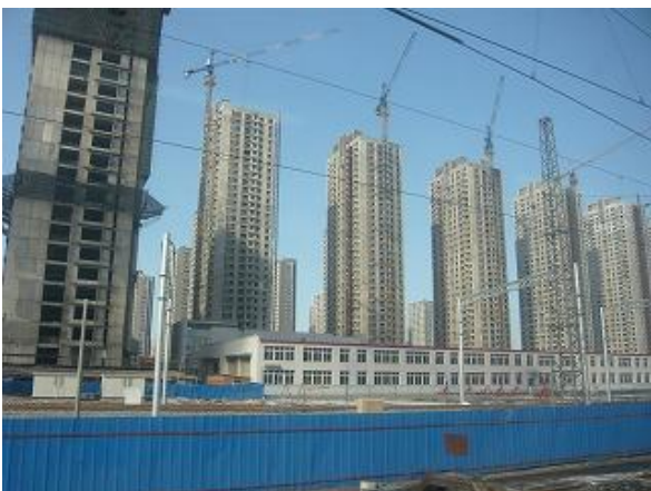
（瀋陽市内で建設中のマンション）
