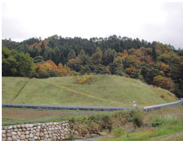
中津河大切坑捨石堆積場
