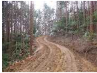
(出来上がった作業道)
