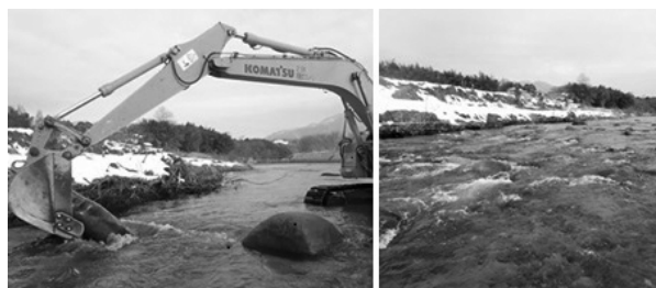
図1 加茂川の育成場造成 (複雑な流れの作出)
