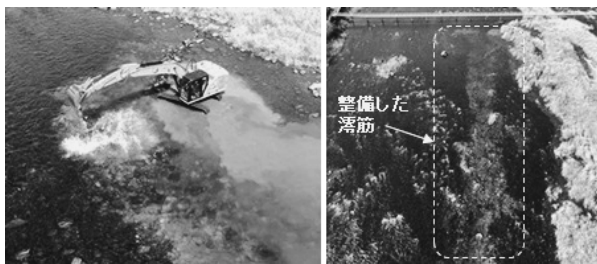
図1 旭川の育成場造成 (平坦な河床に起伏を作出)
