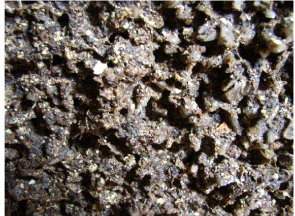
図10 メタン発酵槽内壁に付着した結晶化物
