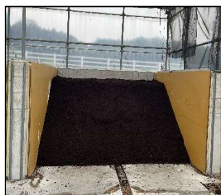
(写真1) 二次処理施設
