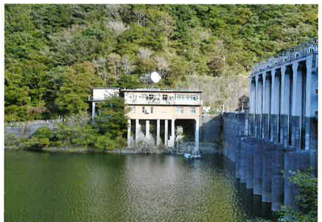
湯原ダム管理事務所
