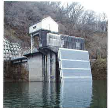
えん堤上流の取水塔
