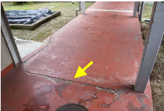
② 廊下に亀裂がある。
