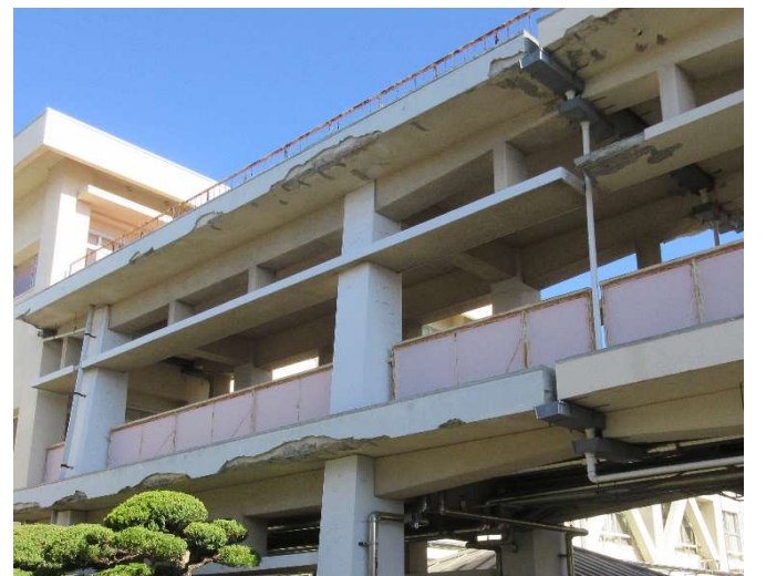
③ 危険箇所を斫り、錆止め対応している。
