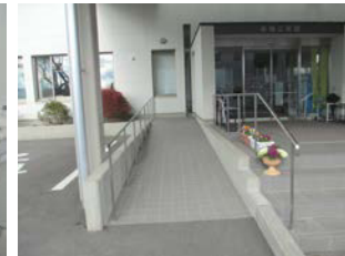
出入口の段差解消 事業費: 30万円程度
