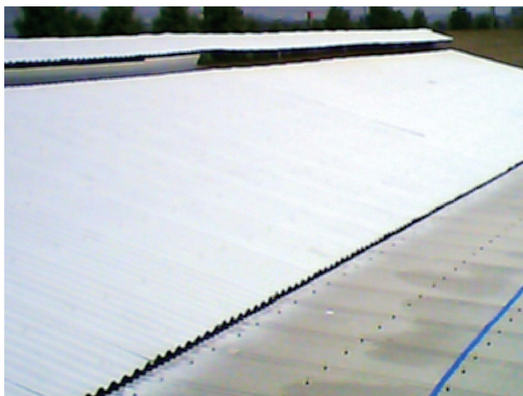
左:断熱塗料を塗布した白い屋根
