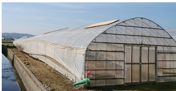
被災したビニルハウス
