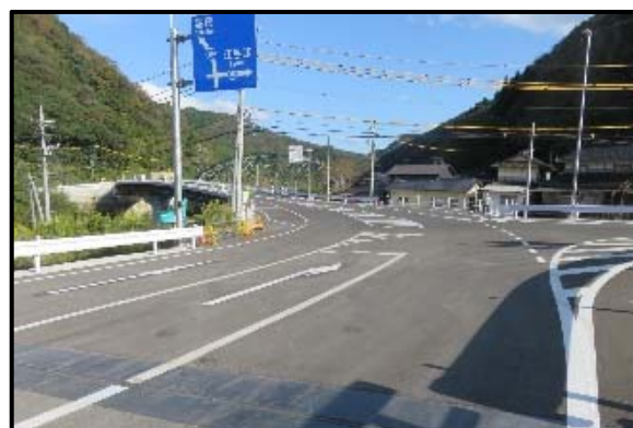
【県道落合建部線(旦土橋)】
