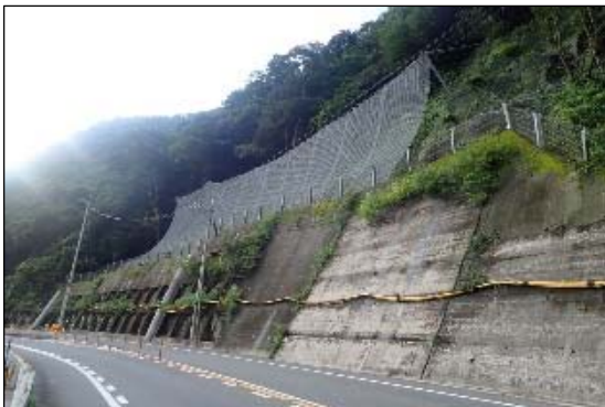
【国道180号(落石対策)】
