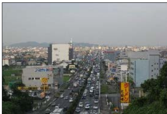
【国道2号(岡山市～倉敷間)(現況)】
