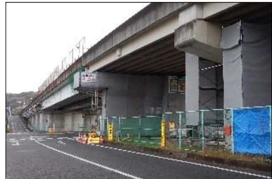
【県道藤戸連島線 連島高架橋(整備中)】
