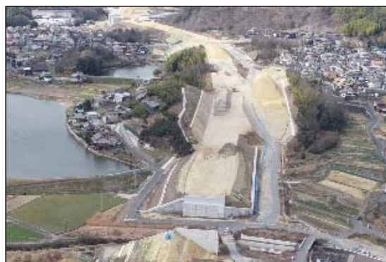
【倉敷福山道路(鴨方IC付近整備中)】
