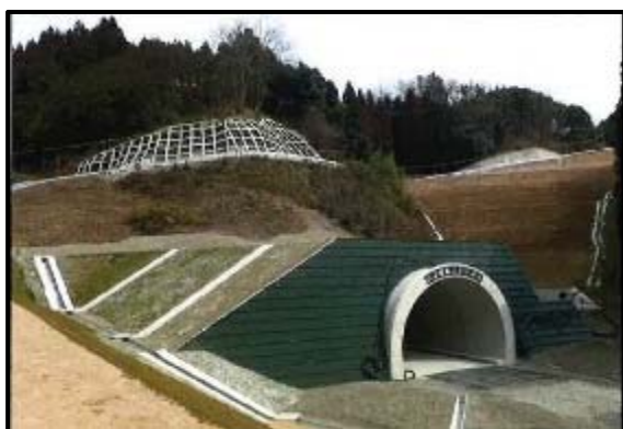
【国道429号旭バイパス(江与味第二トンネル)】
