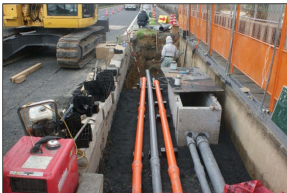
【国道179号(管路整備状況)】
