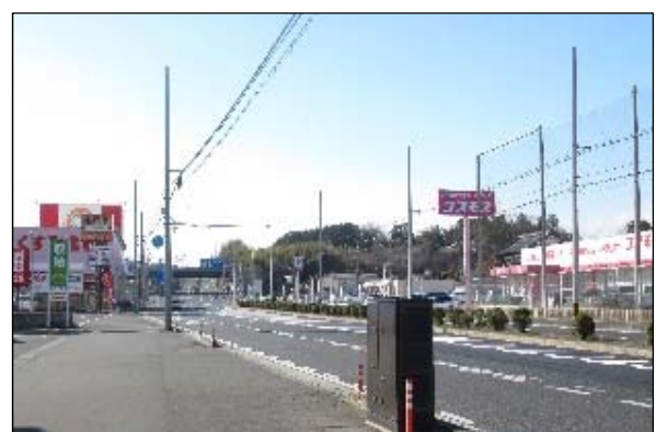
【国道179号(入線作業中)】
