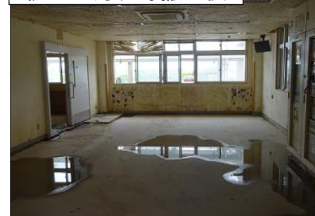
校内の汚泥等撤去後
