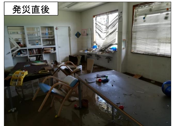
発災直後 障害者施設の被災状況
