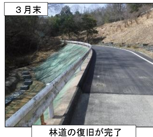
林道施設の復旧状況（岡山市北区建部町）
