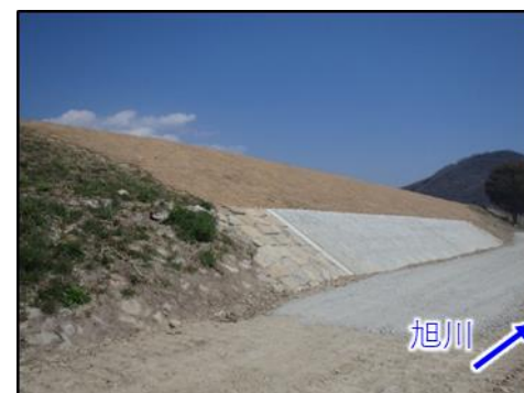
旭川（岡山市北区御津国ヶ原）の施工状況
