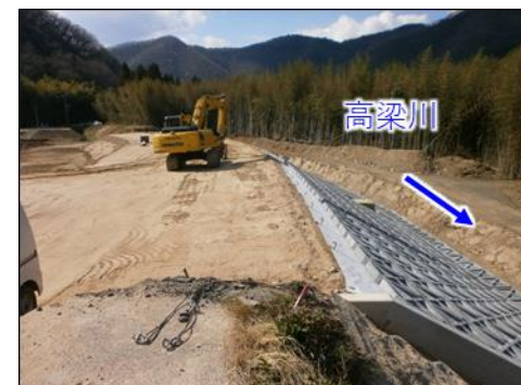
高梁川（総社市下倉）の施工状況
