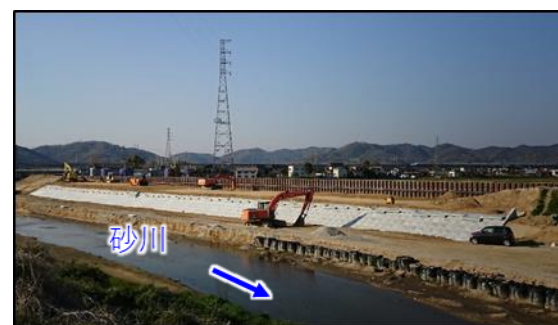
砂川（岡山市東区沼）の施工状況
