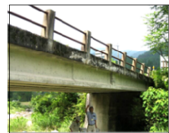
職員による点検状況
