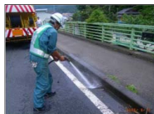
水抜孔清掃状況
