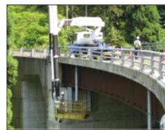
橋梁点検車による点検状況
