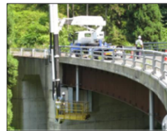
橋梁点検車による点検状況
