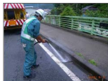
水抜孔清掃状況
