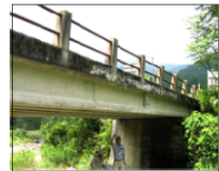
職員による点検状況
